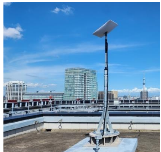
【ビル屋上へのアンテナの設置風景】
